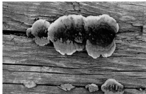
Bild 3.75 Charakteristisches Wachstum von Blättlingen aus Trockenrissen
