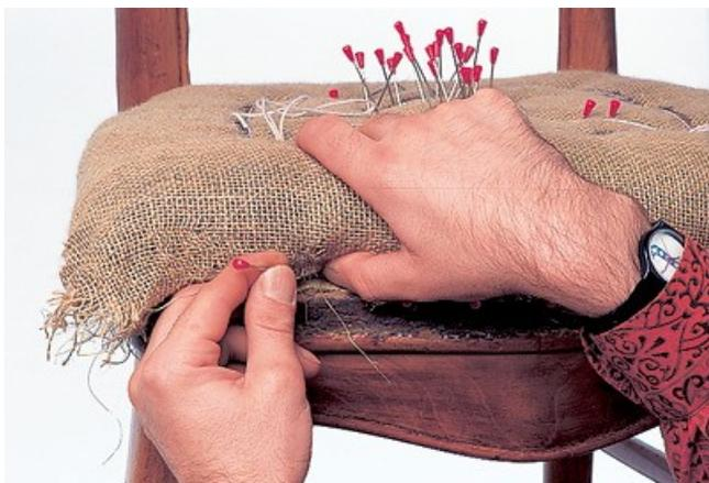
Подогните материал по краям и закрепите булавками. С помощью шила разровняйте наполнитель так, чтобы получилась плотная и равномерная укладка.
