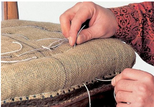
Первую точку прошивки сделайте на concentрической линии в 2 см от основной точки. Шов выполняется под углом. Иголку воткните в горизонтальную поверхность стула, а вытащите в вертикальной.
