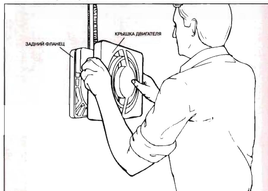
**2 Крепление вентилятора.** С внутренней стороны стены врежьте задний фланец в патрубок и наметьте крепежные отверстия на стене. Просверлите отверстия, вставьте пробки и закрепите задний фланец шурупами. Продолбите канавку для кабеля и защитной трубы и подсоедините кабель к
