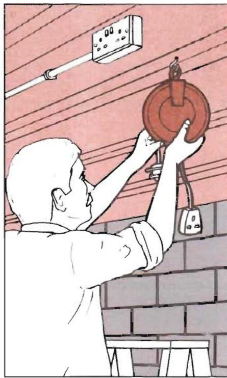
**Подвесная розетка.** Вверните крюк в балку или бетонный поголок, просверлив отверстие и забив пробку, и подвесьте на нем удлинительную катушку: в таких катушках удобно хранится шнур длиной 12,5 м и более. Установите корпус розетки на балке недалеко от штекпеселя катушки и проложите кабелепровод и кабель от корпуса розетки к источнику питания. Поставьте крышку на корпус розетки и вставьте штекпесель катушки в розетку.
