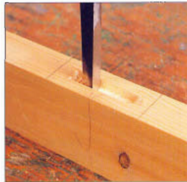
Realice una serie de cortes en la caja con un formón.
