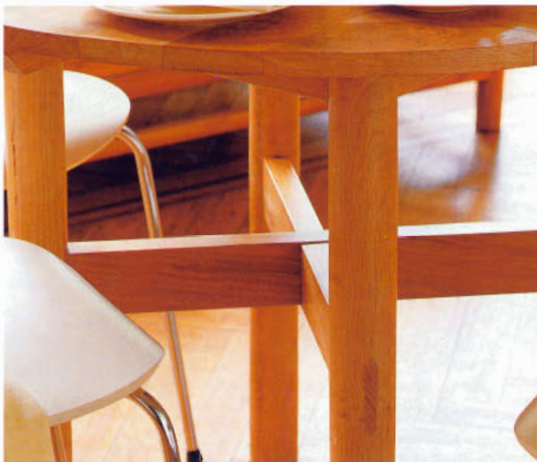
Mesa con travesaños ensamblados a media madera (ver páginas 218 a 222).
