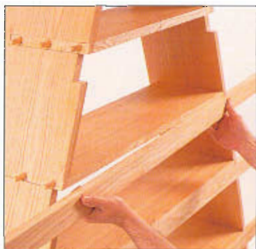
Cerciórese de que los listones quedan paralelos entre ellos.
