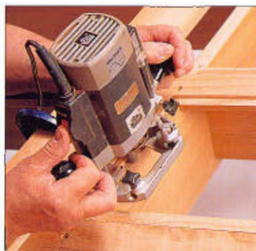
Corte los rebajes para los paneles traseros.
