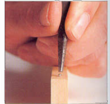
Clave una punta con el botador para clavos para no dañar la madera.
