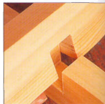
Compruebe en seco el ensamble.
