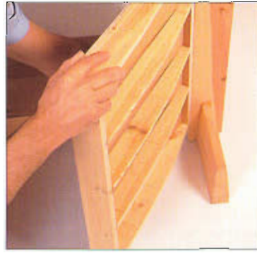
Compruebe el ajuste de las puertas inferiores antes de fijarlas.
