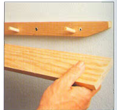
Fije la tira trasera a la pared, y coloque el estante sobre las espigas.
