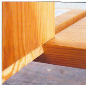
Deslice el estante por la ranura del ensamble.
