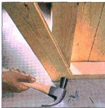
Внешнюю обшивку сауны можно прибить обычными гвоздями - они не могут раскалиться и стать причиной ожогов.
