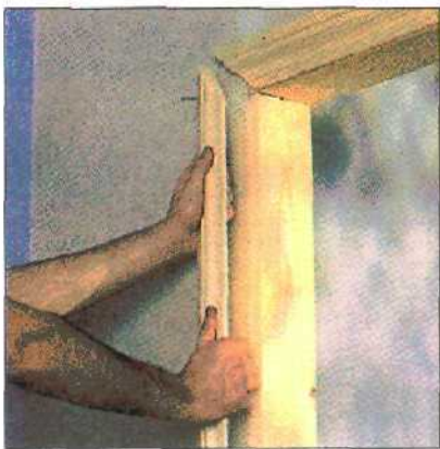
Профильная рейка ~ обрезанная под углом 45 градусов - закрывает место стыка дверной рамы и гипсокартонной панели.
