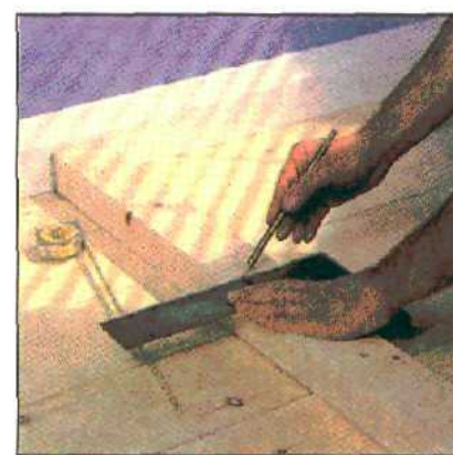
Местоположение вертикальной опоры обозначьте так, чтобы стык двух гипсокартонных панелей приходился на середину.
