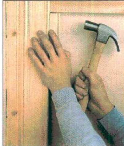
С помощью вспомогательного бруска и молотка установите первую доску шипом внутрь. Канавка должна быть открыта.
