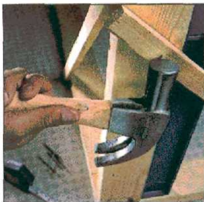
Диагональные связи из обрезков досок предохранят конструкцию от перекоса, пока не будет сделана обшивка.
