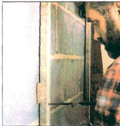
5. Здесь для выравнивания подкладывается фанерная полоса. Привинтите ее к решетине, чтобы она не сдвинулась.
