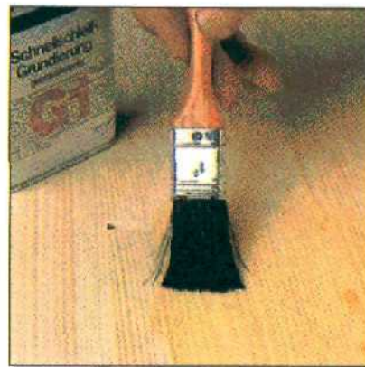
На подготовленную поверхность аккуратно нанесите плоской кистью разбавленную грунтовку.
