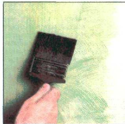
Собственно окраска осуществляется кисточкой. Вертикальные мазки способствуют равномерно распределению краски.
