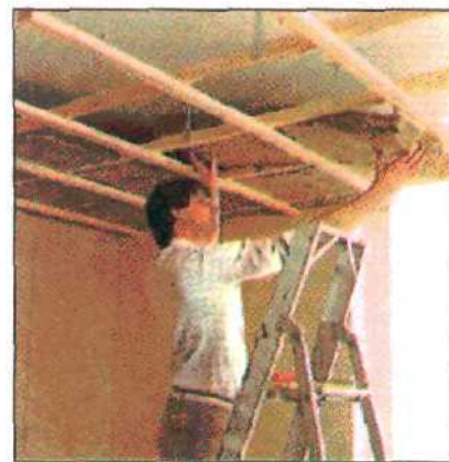
Изоляционный слой, уложенный под потолком, улучшает звукоизоляцию и сокращает расходы на отопление.
