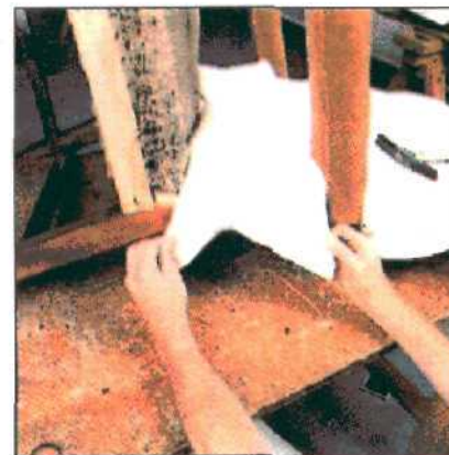
4. Углы ткани натягиваются туго вокруг опоры и прибиваются к нижней стороне перекладины. Следите, чтобы на ткани не было складок.
