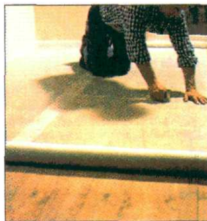
Стекловолоконную ткань раскатывают и закрепляют скобами. Полотна заходят одно на другое на 5 см.
