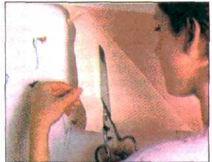
Оттяните край полотнища и аккуратно отрежьте по линии изгиба.
