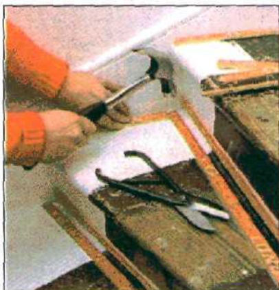
Рейки с гвоздями прибивают по краю и бокам ступени, а также по нижнему краю подступенка.
