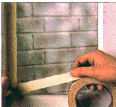
Самоклеящаяся креповая лента предотвращает попадание краски на стекло.
