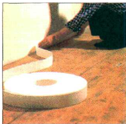
По периметру стен укладывают тонкие пенопластовые полоски. Они служат температурными швами.
