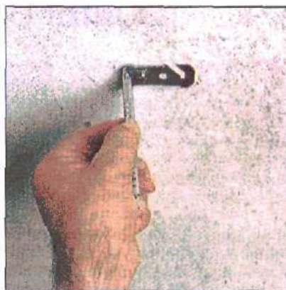
2. Держатель нужно согнуть и выровнять ряд таким образом, чтобы подвижные части попеременно скреплялись с решеткой слева и справа.
