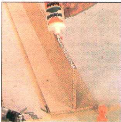
3. Отметьте среднюю линию верхней полосы, нанесите клей и привинтите ее к Т-образному профилю, прикрепленному к полу.
