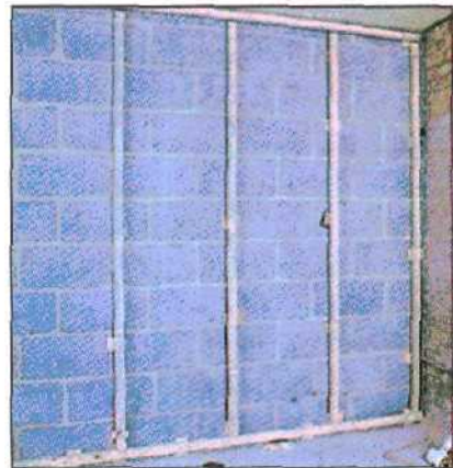
6. Готовая внутренняя обрешетка с подложенными элементами. Они обеспечивают внутреннюю вентиляцию.
