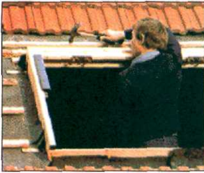
Прибейте гвоздями к стропилу над коробкой дополнительную планку. На ней будет укреплен верхний фартук наружной рамы.
