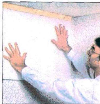
2. Поверхность стены между планками покрывается пенопластовыми пластинами или нетканым материалом.
