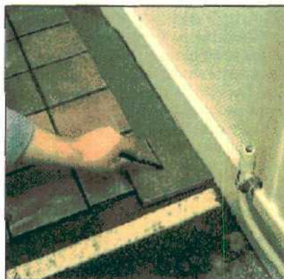
4. Примерить и уложить крайние плитки. Если у стены обнаружится укос, то проследить за размером пристенного зазора.
