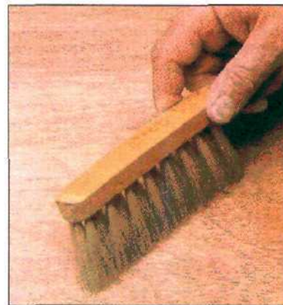
Жесткой щеткой или чистым веником с поверхности дерева удаляют всю пыль.
