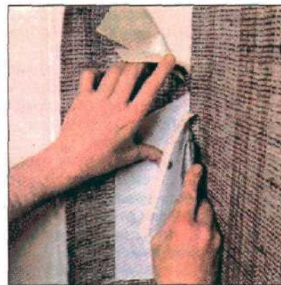
Основное полотно лежит на угловой полоске. Если теперь продавить оба полотна, то получится соединение внахлест.
