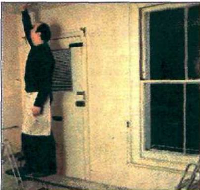
Помост установлен правильно, если, стоя на нем, можно кистью руки легко дотронуться до потолка.
