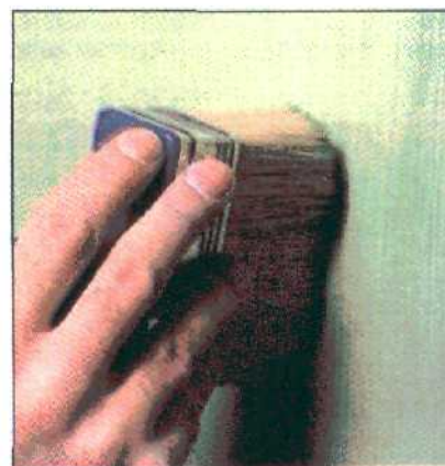
Равномерное постукивание кистью по окрашенной поверхности создает тонкозернистую фактуру.
