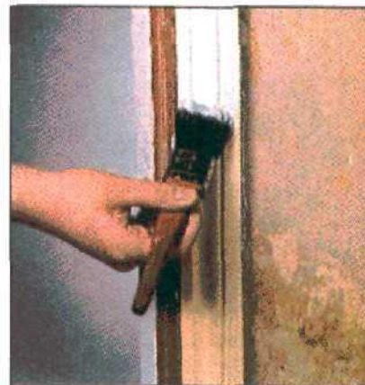
Грунтовку не следует наносить слишком толстым слоем, чтобы избежать образования "луж".
