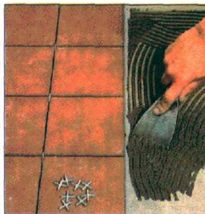
Плиточный клей наносится на основание с помощью зубчатого шпателя. Крестообразные прокладки обеспечивают равномерность ШВОВ.
