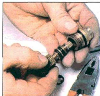
На боках шпинделя видны оба O-образных кольца, которые, правда, редко, но тоже приходится менять.
