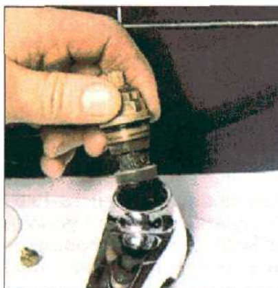
После того как вы отделили вентиль, удалите из его седла всю грязь, а также почистите корпус крана.
