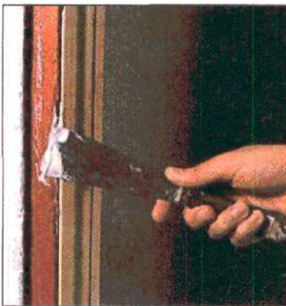
Маленькие неровности шпаклюются узким шпателем, большие - широким.
