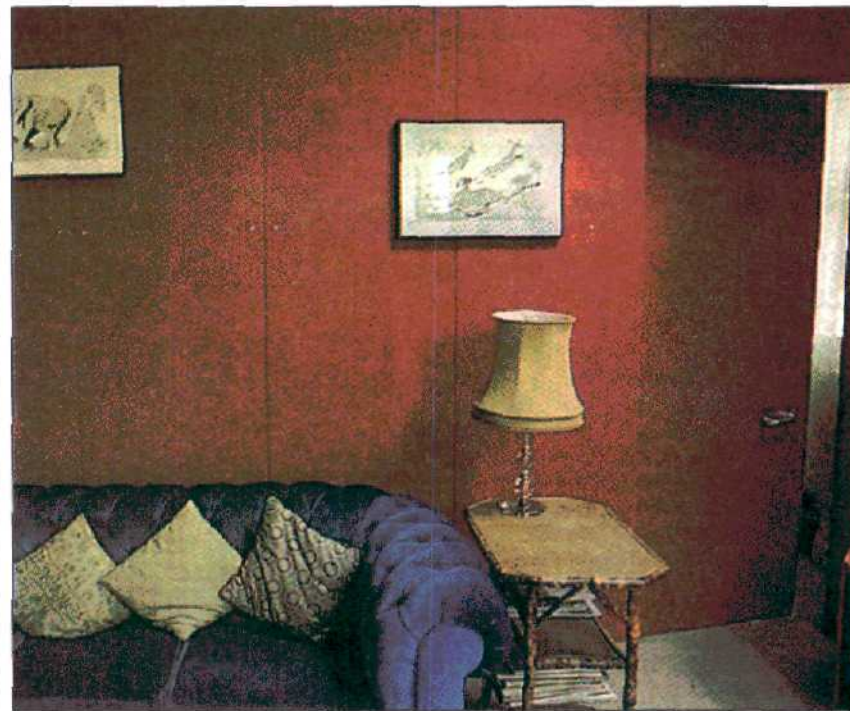
Дверь также можно обить декоративной тканью – благодаря этому вы получите единый тон отделки. В данном случае не нужно ни шпаклевать, ни красить. Дверь декорируется так же, как и стенные панели. Ткань просто подгибается и приклеивается к полотну двери.
