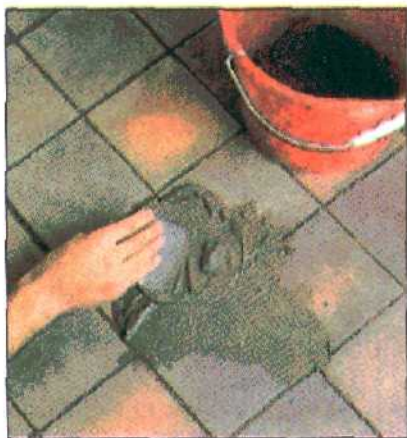
После этого не очень жидким раствором с помощью резинового или пластмассового шпателя швы замазываются и заглаживаются.
