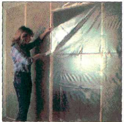
Плотную пленку уложить в качестве парозащиты на обогреваемой стороне перегородки. Укрепить скобами, сделать дверной проем.
