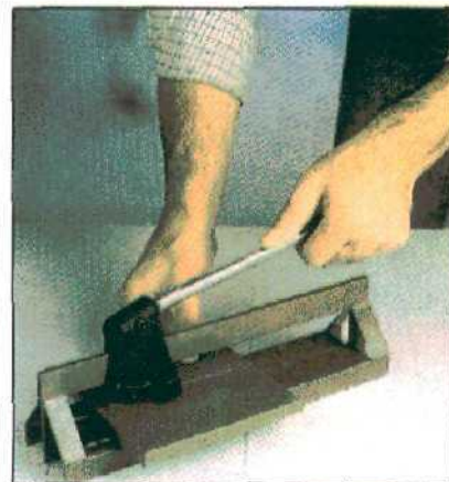
Кирочкой для плиточных работ аккуратно расколоть плитки точно по намеченной линии.
