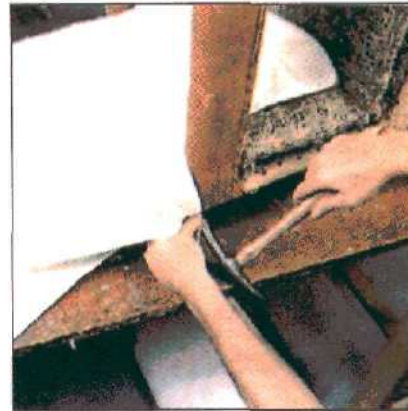
2. Углы ткани аккуратно загните внутрь, подтяните вплотную к опоре и прибейте гвоздями под натяжкой.
