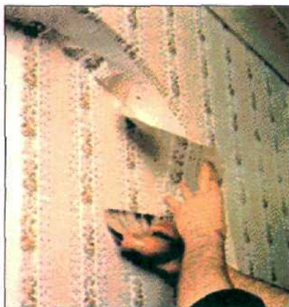
4. После подгонки приклейте полотнища обоев на внутреннюю часть арки. Обрежьте выступающие участки, оставив резервную полосу шириной 25 мм.
