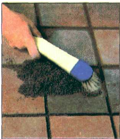
Слегка влажный раствор заметается кистью в швы, которые заполняются почти доверху.
