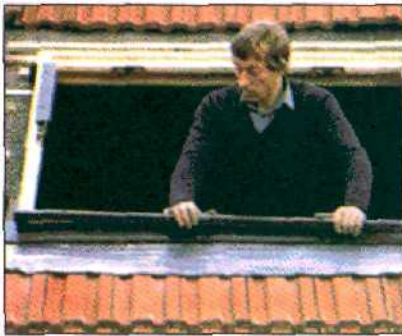
На нижней части наружной рамы, состоящей из четырех частей, находится фартук из пластичной свинцовой жести.
