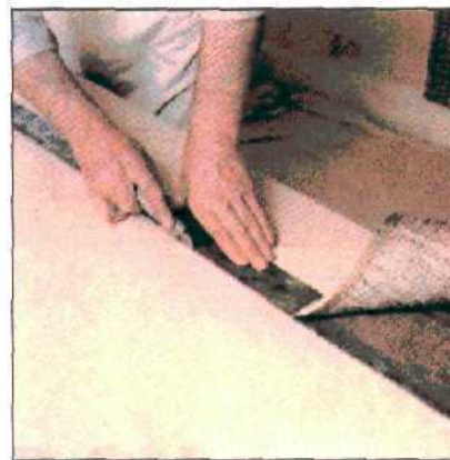
Если вы режете обои монтажным ножом, то как можно сильнее прижимайте к полотну стальную линейку. Иначе волокна могут обтрепаться.
