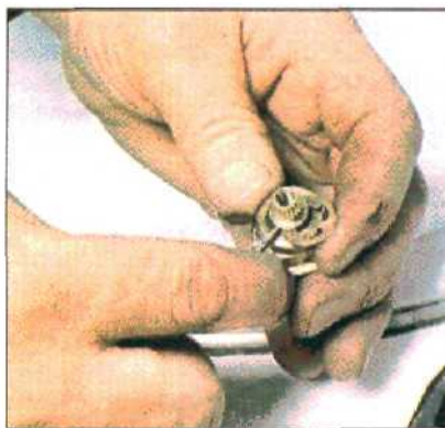
Для замены уплотнителя сначала нужно отделить стяжное кольцо, а затем уже шпindel и верхнюю часть крана.
