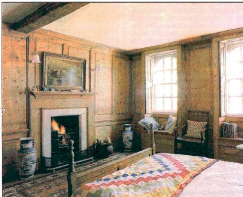
Комната, облицованная большими плитами, как бы наполнена уютным покоем. Профильные планки не только закрывают стыки плит, но и являются важным элементом оформления.
