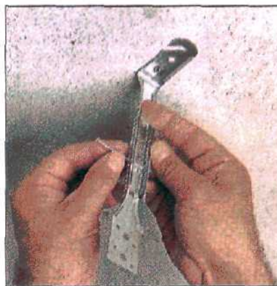
4. Обе части скрепляются гвоздем. Подбирая для гвоздя отверстие, можно юстировать расстояние с точностью до миллиметра.
