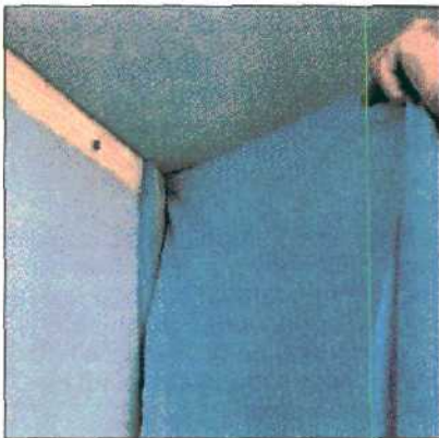
5. Полотно заворачивается вокруг вертикальной планки и прибивается скобами к верхней планке.
