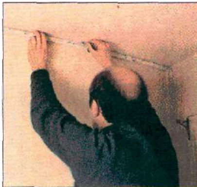
Полотнища наклеиваются параллельно стене, где расположено окно.
