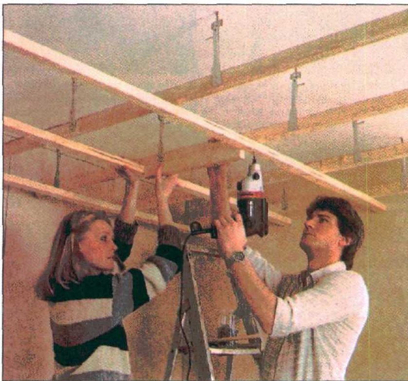
Брусек-шаблон помогает привинчивать контрбрусья к основной обрешетке на одинаковом расстоянии.
