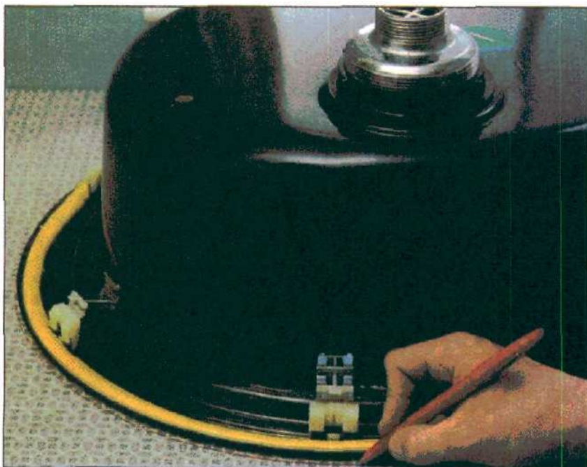
Линия, проведенная вокруг мойки, является вспомогательной. Вторая, проведенная параллельно ближе к центру, - линия распиливания.
