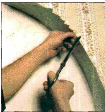
2. Прежде чем загнуть край, надрежьте его с интервалом в 25 мм. Пользуйтесь только очень острыми ножницами.
