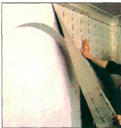
1. Чтобы оклеить обоями арочную нишу, разместите первое полотнище рядом с предыдущим так, чтобы оно выступало за край арки.
