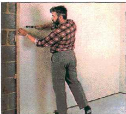
7. К обрешетке приколачиваются или привинчиваются панель за панелью. Внизу вставлен клин, чтобы панели не касались пола.
