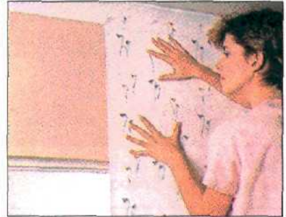
Полотнище приложите так, чтобы обрезной край входил в скос окна.
