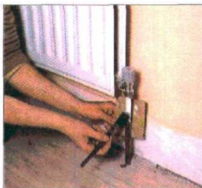
Картонка защищает стены от брызг краски. Таким же образом их можно защитить и при окраске подоконника.
