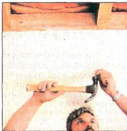
6. Используйте оцинкованные гвозди длиной 60 мм. Вбивайте их на расстоянии 15 см друг от друга, осторожно, чтобы не было вмятин в панели.
