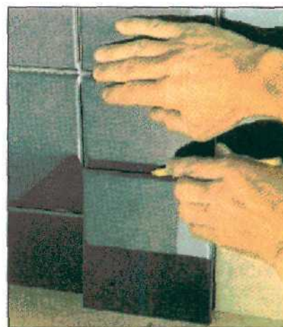
Когда клей высохнет, снимите планки и отметьте плитки, которые нужно укоротить.
