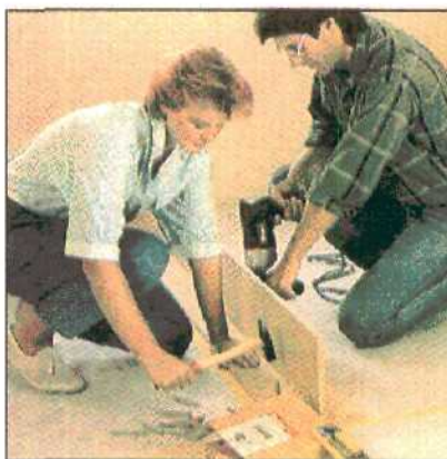
2. Соедините профильную полосу с вертикальной, чтобы при дальнейшем монтаже у вас была свобода действий.
