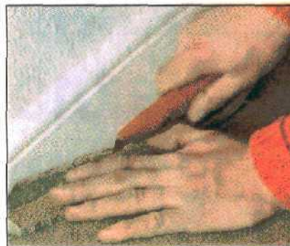
Пристенные края аккуратно обрезают ковровым ножом и слегка прижимают ворс книзу.
