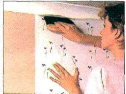
Верхний край выступает на 5 см. Загните и повторите контур угла.
