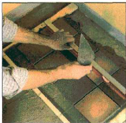
3. Ровно уложить напольные плитки, прижать легким постукиванием и выверить горизонтальное положение уровнем и угольником.
