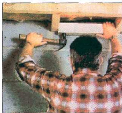
2. В том месте, где будет висеть люстра или другой тяжелый предмет, поставьте на всякий случай крепежный элемент.
