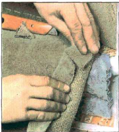
В подвернутом крае вырезают треугольники, чтобы не образовались морщины и пузыри.
