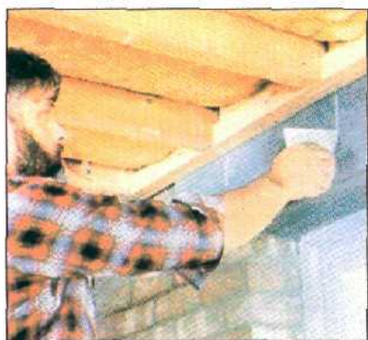
1. Отметьте положение несущей балки, чтобы позднее, когда весь потолок будет обшит панелями, вы смогли найти ее.
