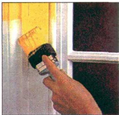
Манжет из губки на крепежном кольце кисточки не позволит краске стекать на руку,
