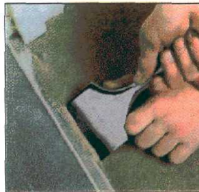
Край ковра вы можете зажать таким рельсом, в котором ряды гвоздей закрыты металлической планкой.
