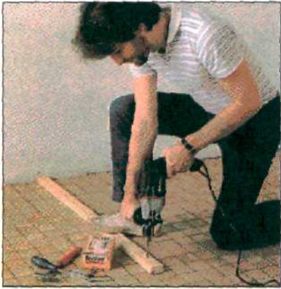
Просверлить через уже просверленные рейки отверстия в полу для дюбелей на расстоянии около 60 см.
