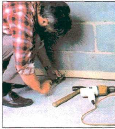
2. Опорная решетина должна как бы "парить" над полом. Потом вы сможете выровнять все вероятные неровности.
