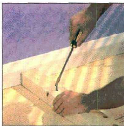
Нижний брус привинчивается к полу. Просверлите отверстия нужного диаметра и после завинчивания болтов утопите их головки.
