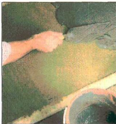
2. Более жидко разведенный раствор нанести тонким слоем на основание пола и равномерно распределить лопаткой.
