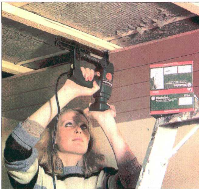
Электрический скобовбиватель значительно облегчает закрепление досок. С ручным скобовбивателем или молотком дело идет медленнее.
