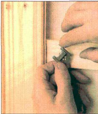
Бортик канавки захватывают профильной скобой, которая лежит на несущей рейке.
