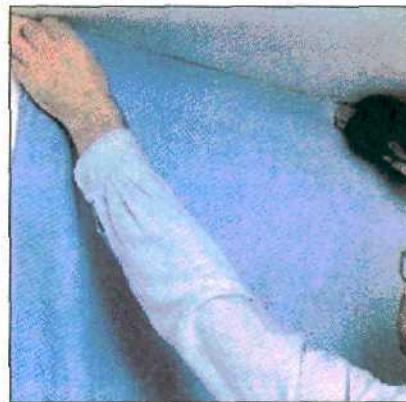
6. Прибивая скобы, полотно натягивают равномерно. После того как его закрепят сверху, прибивают нижний край.
