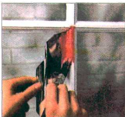
Кусок картона, меди или пластмассы может служить в качестве "перемещающейся" защиты. Обратная сторона приспособления должна быть чистой.
