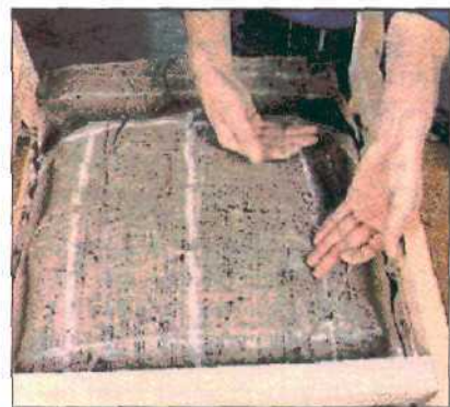
5. От пружины к пружине по прямой протягиваются петли шириной в ладонь под набивочный материал.
