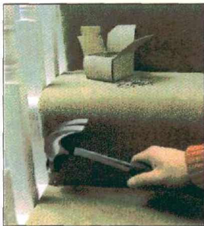
Край укладывается до перил или до края ступени и прибивается гвоздями,
