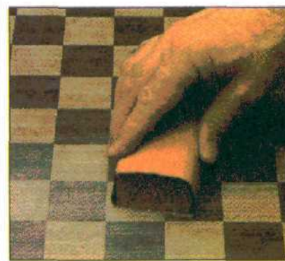
После грунтовки неровности устраняют мелкозернистой наждачной бумагой или мотком тонкой стальной проволоки.
