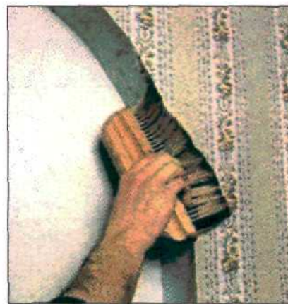
3. Заверните надрезанный край внутрь и обойной щеткой придавите его к откосу арки. Работайте очень аккуратно.
