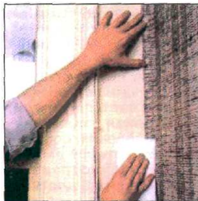
За угол должна заходить только узкая полоска обоев. Маленькие надрезы по кромке позволяют скрыть неровности стены.
