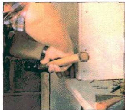
9. При отделке оконного проема сначала обшивается узкой полосой притолока, затем сверху устанавливается панель.
