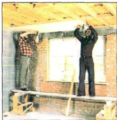
4. Устойчивая подставка и помощник необходимы при обшивке потолка панелями. Начинайте работу всегда с центра.
