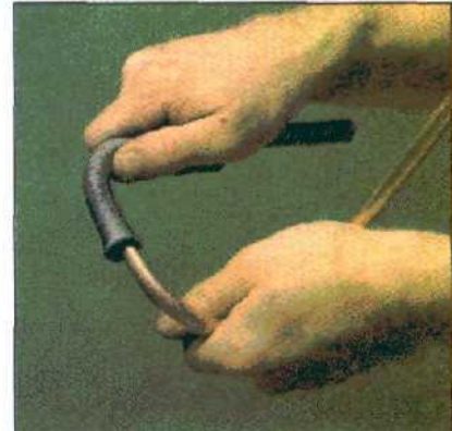
С помощью гибочной пружины медной трубе можно придать любую форму. Имеются пружины для всех труб стандартных диаметров.
