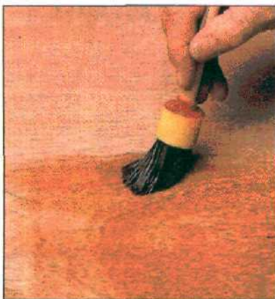
Грунтовку наносят кистью или, как состав для матового покрытия, большим тампоном.
