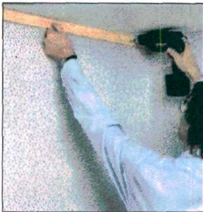
1. Под потолком и у основания стены планки крепятся шурупами. У правого края стены оставить свободным участок, равный ширине планки.
