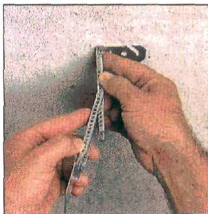
3. Нижняя подвижная часть держателя вкладывается в верхнюю и таким образом устанавливается желаемая высота направляющей.
