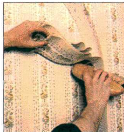
6. Выкройте полосу шириной, соответствующей глубине арки, и приклейте ее.
