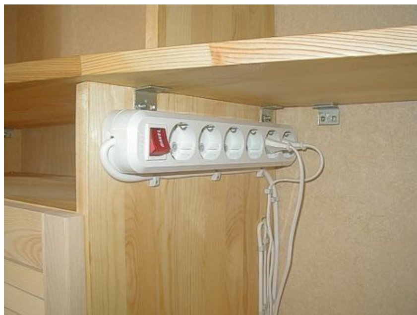
Рис. 17. Крепление блока розеток - так называемого "Пилота".
