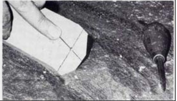
Fig. 6 (en haut, à droite). Première étape du dégrossissage d'un carré en cylindre.
