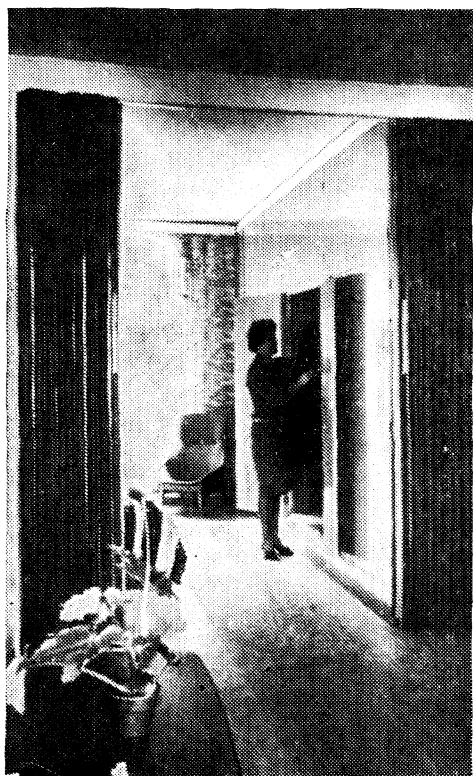
Рис. 13. Шкаф-перегородка в доме по Вятской улице
