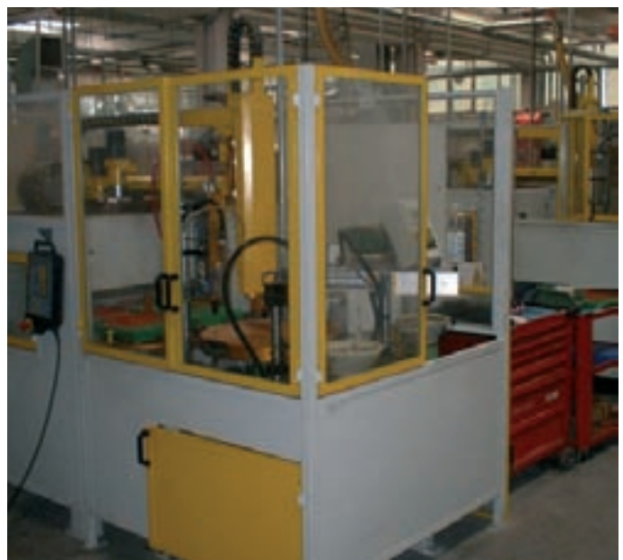
Montaje y marcaje totalmente robotizado
